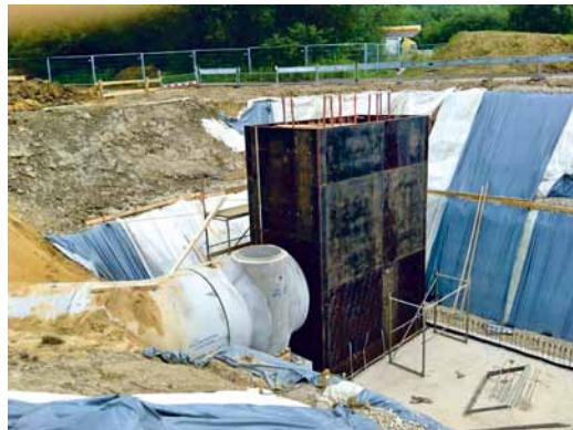
Travaux de construction d'un bassin d'orage et d'une station de pompage (Rodange)
