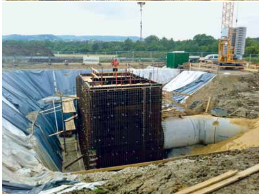
Travaux de construction d'un bassin d'orage et d'une station de pompage (Rodange)
