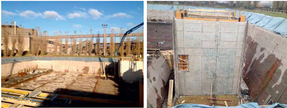
Ferrailage du radier et décoffrage d'une partie du bâtiment de service
