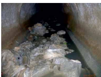
Dépôts constatés dans un collecteur
