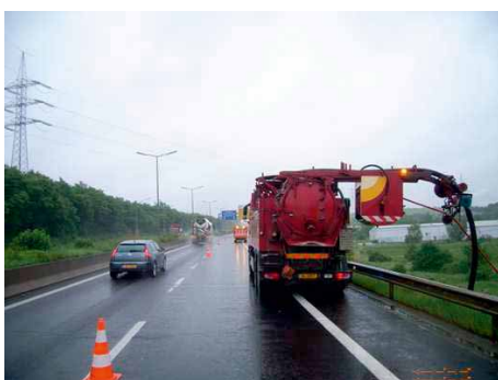
Travaux d'inspection des canalisations
