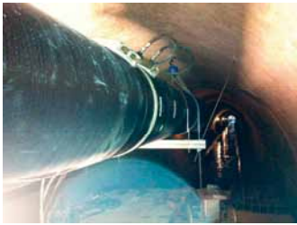
Assemblage des tuyaux par soudage en bout
