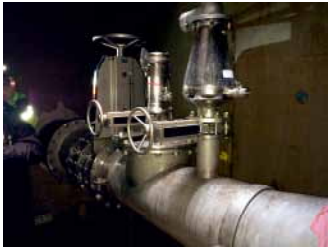
Robinetterie dépassant les caillebotis à l'intérieur d'un regard de visite
