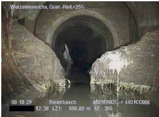
Dégâts constatés : pénétration de racines
