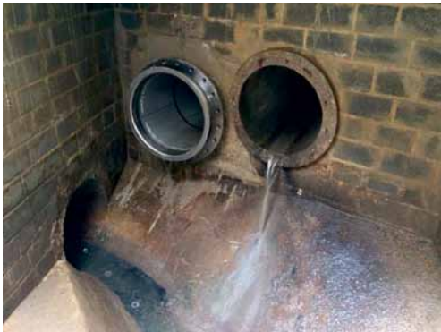
Raccordement de la conduite de refoulement au collecteur principal
