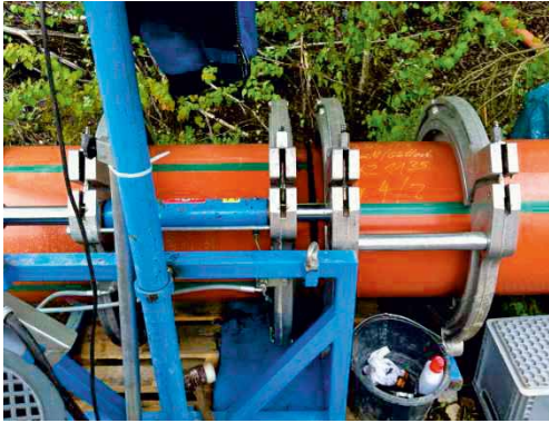
Assemblage des tuyaux par soudage en bout
