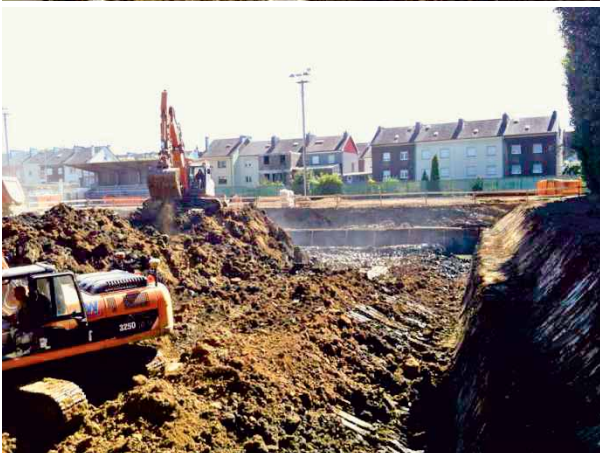
Travaux de terrassement du futur bassin d'orage en cours
