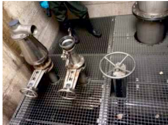
Robinetterie dépassant les caillebotis à l'intérieur d'un regard de visite
