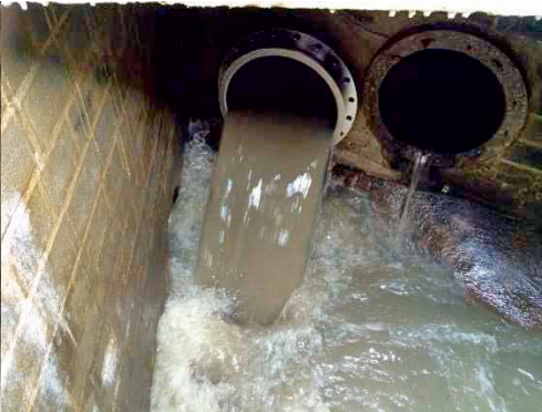
Raccordement de la conduite de refoulement au collecteur principal
