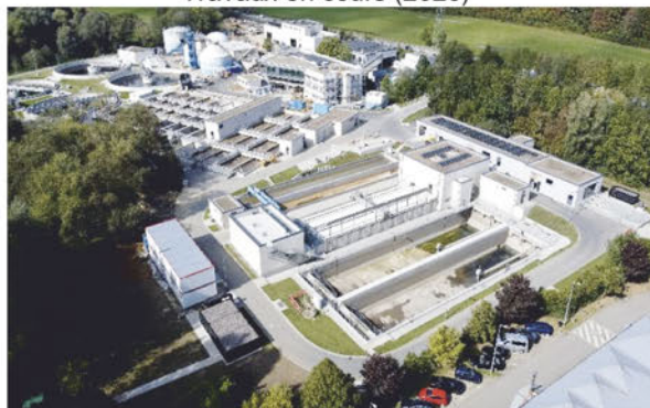
Travaux en cours (2023)
