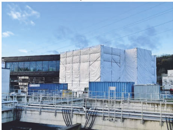
Bâtiment administratif en pleine rénovation
