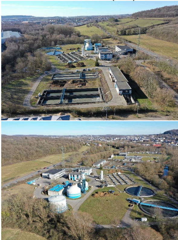
Début des travaux (2019)
