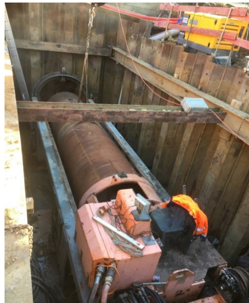
Travaux de fonçage sous la collectrice entre Käerjeng et Pétange
