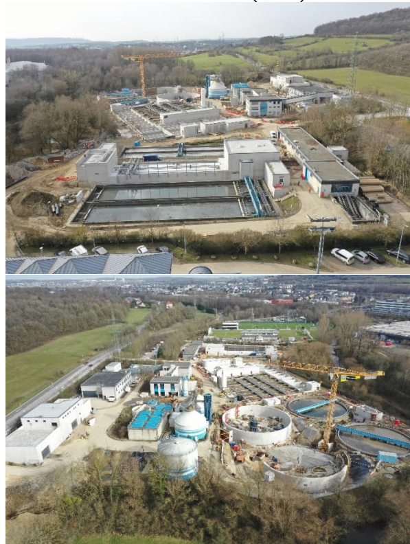
Travaux en cours (2021)
