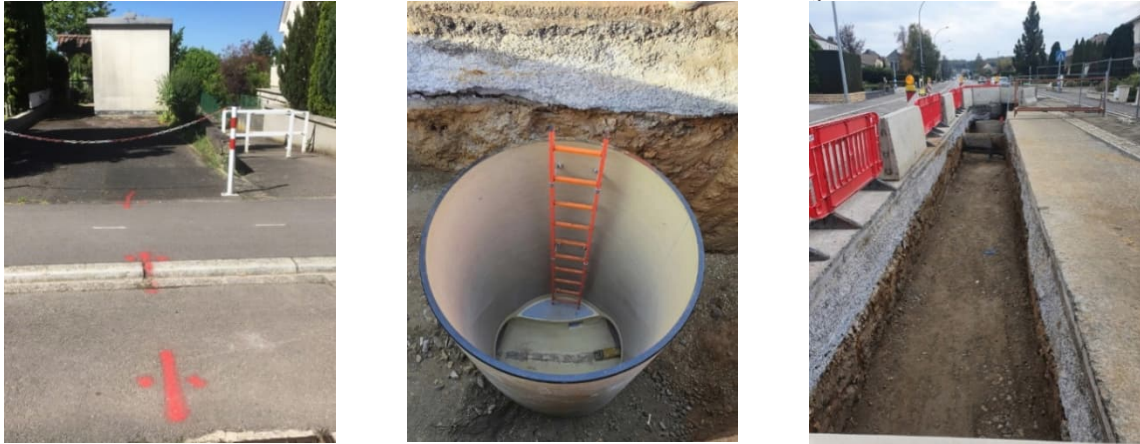
Adaptation et mise en conformité du déversoir RÜB14 - bd Kennedy
