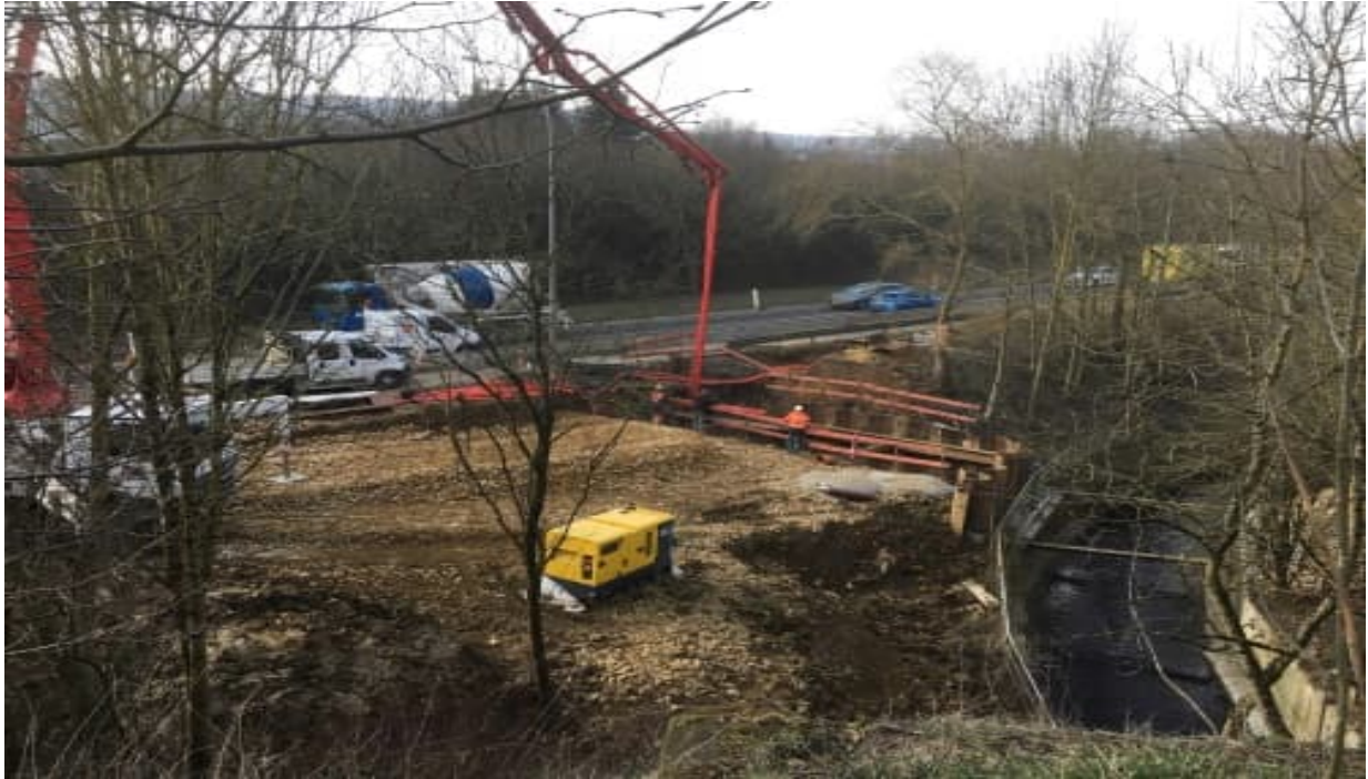
Travaux de fonçage sous la collectrice entre Käerjeng et Pétange
