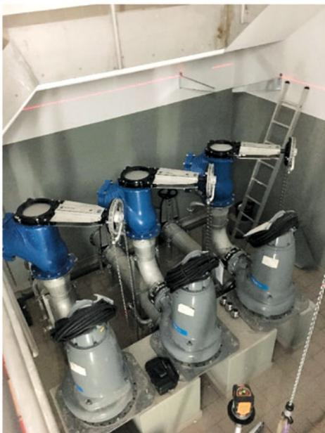
La station de pompage est intégrée dans le local technique du bassin et comprend deux pompes principales ainsi qu'une pompe de réserve. Par temps sec, une seule pompe sera en mesure d'évacuer la totalité des eaux affluentes vers la station d'épuration de Pétange.
