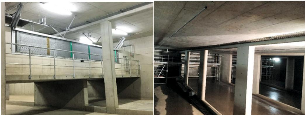
*Le bassin d'orage a une capacité de rétention d'un volume de 3.175m<sup>3</sup>*
