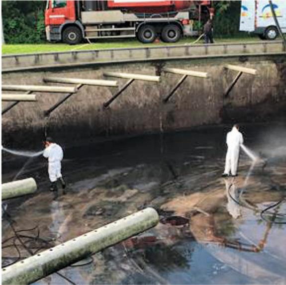
*Nettoyage du décanteur secondaire*
