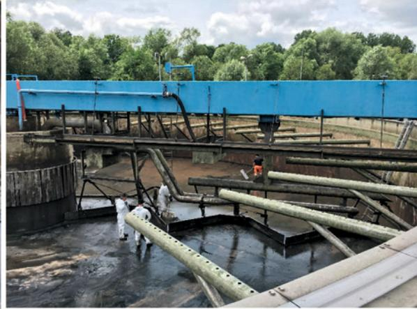
Cette intervention a révélé le besoin urgent de renouveler les racleurs et de réaliser d'importantes réparations au niveau des supports des roues pour racleurs.
