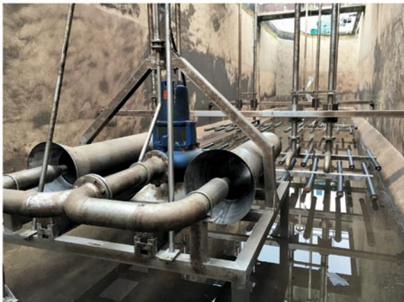
*Installation d'injection et de mélange d'oxygène et de boues activées*
