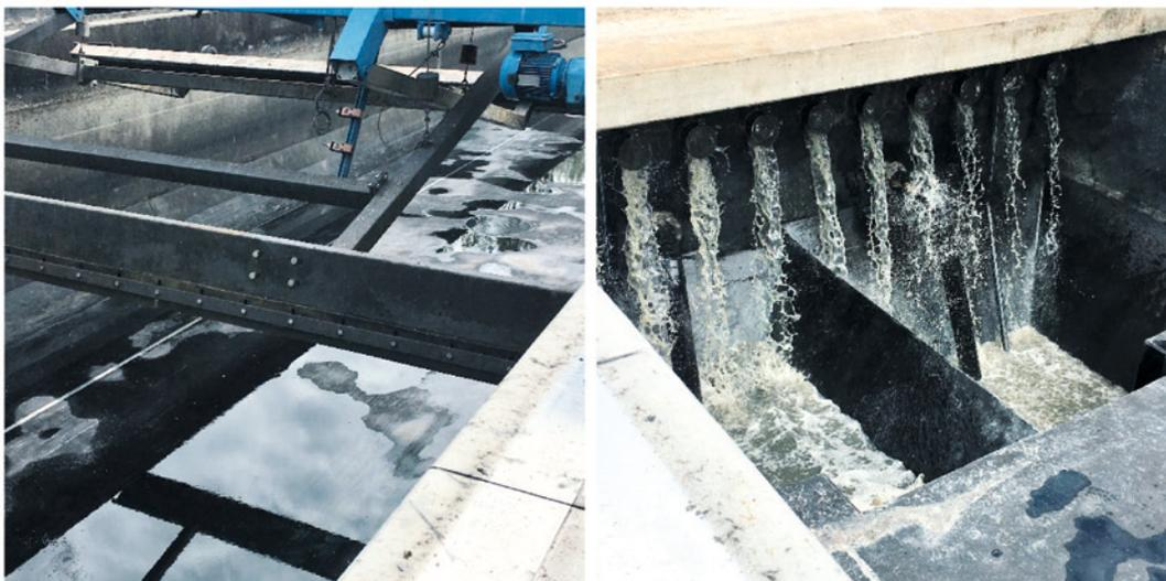
*Vidange du décanteur primaire et remplissage après maintenance*
