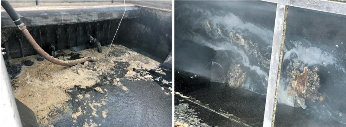
*Vidange du décanteur primaire et absorption du dépôt de graisse*
